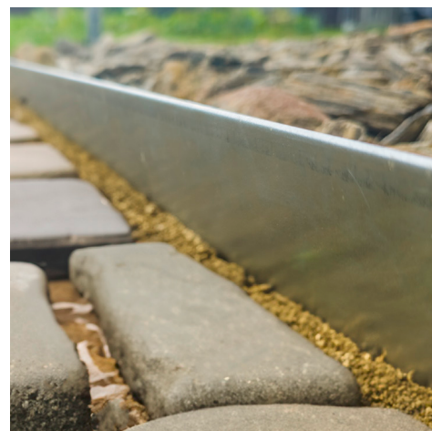
Oddzielenie kostki brukowej od kamieni
