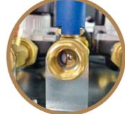
**Miejsce na czujnik sprężęta i czujniki wody zmieszanej**
