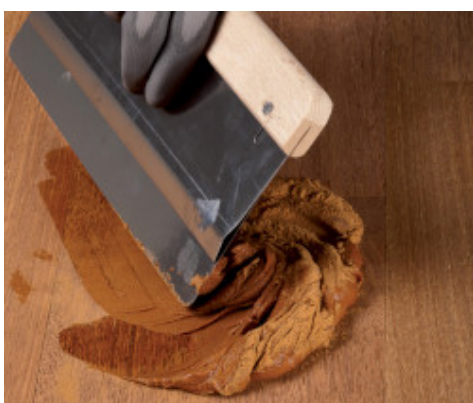
Przygotowywanie szpachlówki z użyciem Ultracoat Binder
