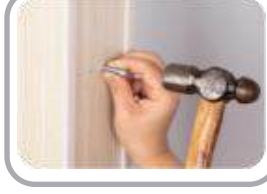
14. Insert the expansion screw En los agujeros.
