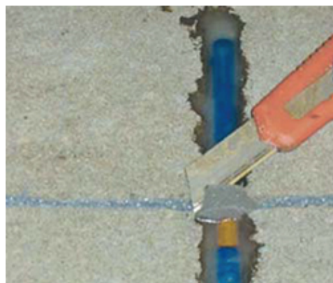
6. Odcinanie nadmiaru pianki ekspansywnej
