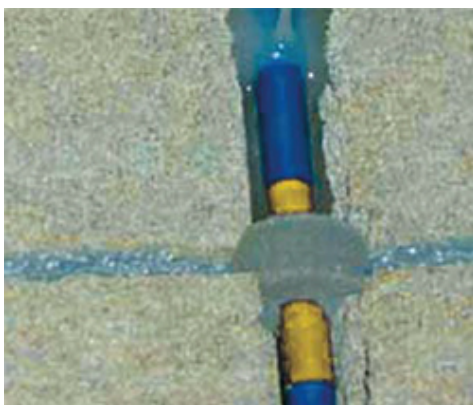
5. Zalewanie dybla żywicą Eporip lub Eporip Turbo
