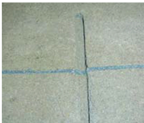
2. Nacięcie przygotowane do instalacji dybla
