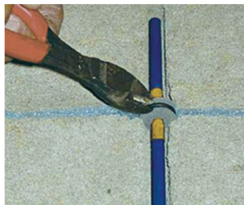
3. Usuwanie pierścienia zaciskowego z pianki ekspansywnej
