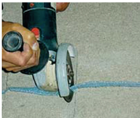
1. Wykonywanie nacięcia w celu włożenia dybla
