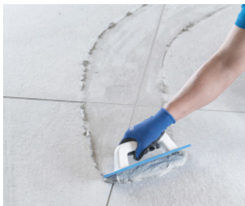
Spoinowanie zaprawą Keracolor GG za pomocą pacy MAPEI
