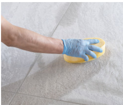
Czyszczenie i profilowanie spoin gąbką celulozową
