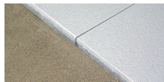
Montaż na podbudowie lub podbetonie
