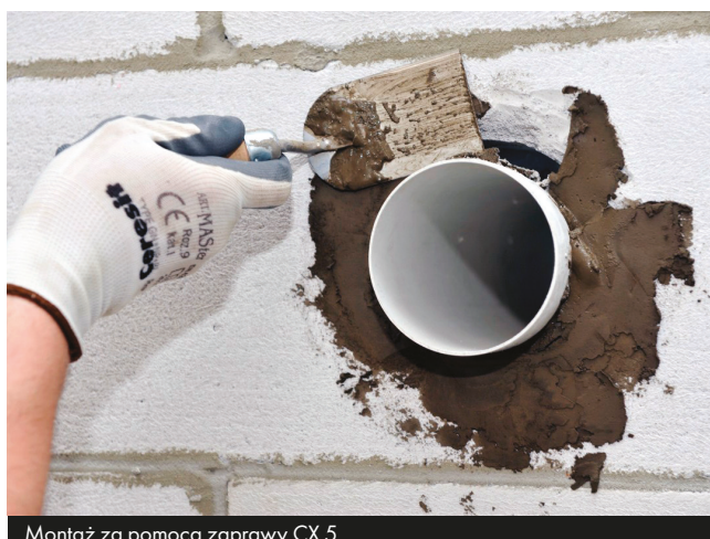
Montaż za pomocą zaprawy CX 5
