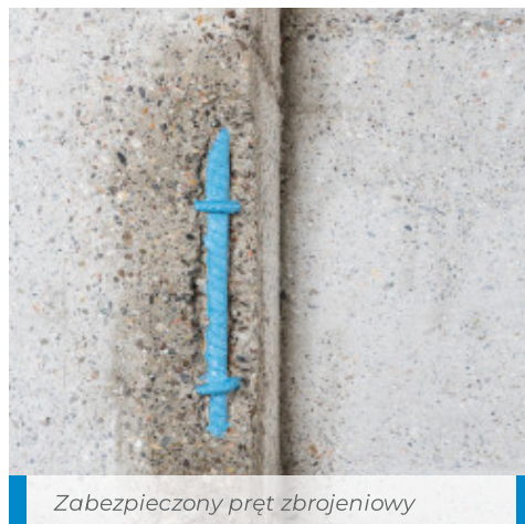
Aplikacja Mapefer 1K Zero na prętach zbrojeniowych wiaduktu
