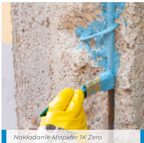
Aplikacja Mapefer 1K Zero na prętach zbrojeniowych wiaduktu
