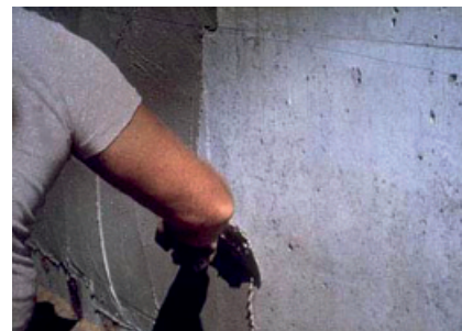
Zaprawę PCI Barraseal® 2K Objekt można nanosić pacą, pędzlem lub przy pomocy urządzenia natryskowego
