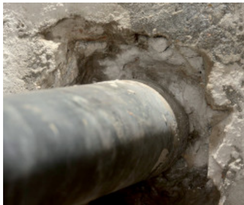
Wyburzenie fragmentu betonu wokół rury
