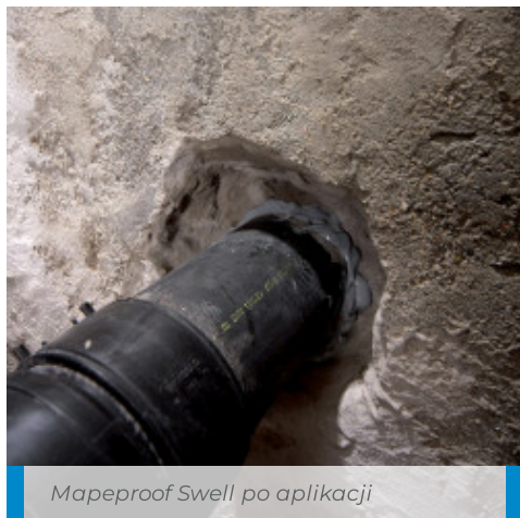
Wyburzenie fragmentu betonu wokół rury
