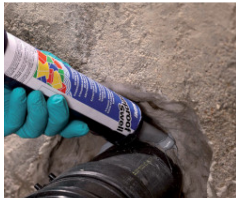
Nakładanie Mapeproof Swell wokół rury
