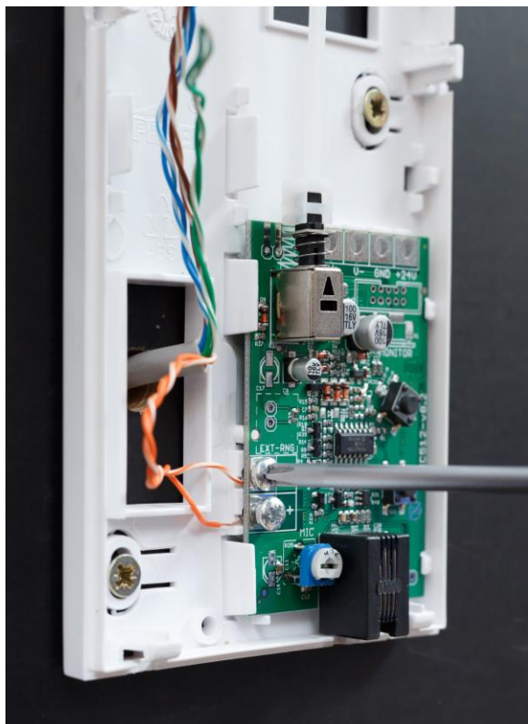
Fot. 8 Przykręcanie przewodów w kanałach.
