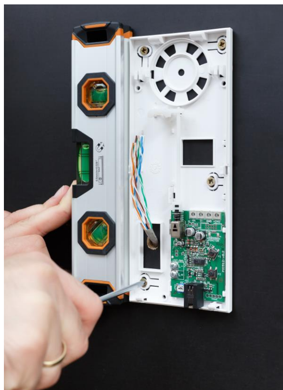
Fot. 6 Dokręcanie wkrętów montażowych.
