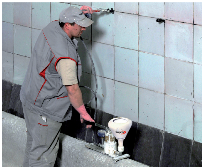
Aplikacja płynnej zaprawy Soprodu ® 900 za pomocą metody iniekcyjnej
