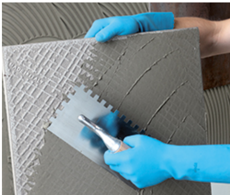
Rozprowadzanie kleju na spodniej stronie płytki
