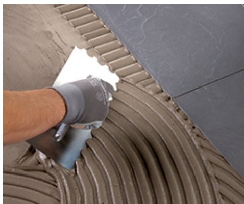
Rozprowadzanie kleju na posadźce za pomocą pacy z okrągłym zębem
