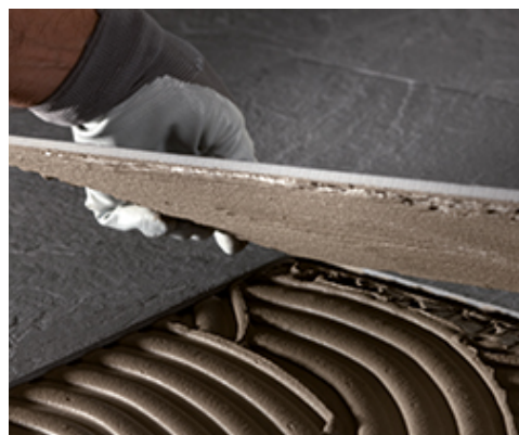
Montaż cienkiej płytki z gresu porcelanowego na podłodze
