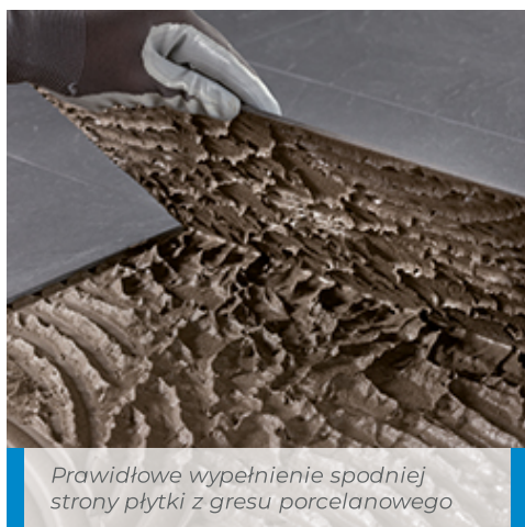
Rozprowadzanie kleju na posadźce za pomocą pacy z okrągłym zębem
