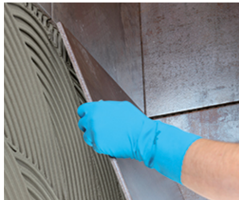
Montaż płytek wielkoformatowych na ścianie
