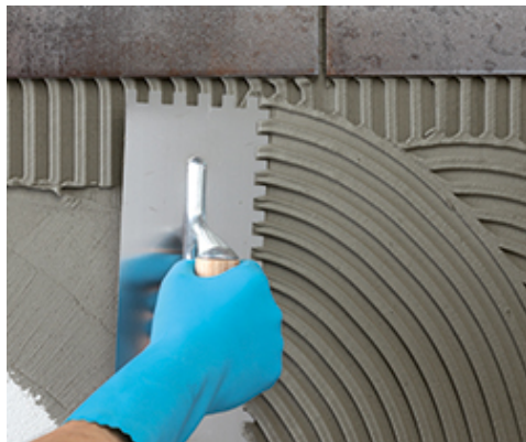
Rozprowadzanie Ultralite S1 pacą zębątką na ścianie
