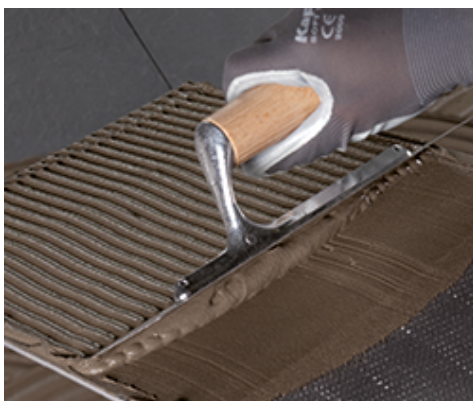
Rozprowadzanie kleju na spodniej stronie płytki
