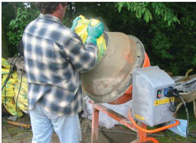
1 Przygotowanie zaprawy drenażowej Sopro DM 610 w betoniarnie wolnostopadowej.
