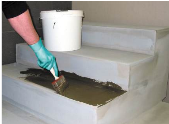
2 Naniesienie podkładu przyczepnego, elastycznego z traselem Sopro HSF 748 na uszczelnienie zespolone jako warstwy kontaktowej dla zaprawy drenażowej Sopro DM 610.
