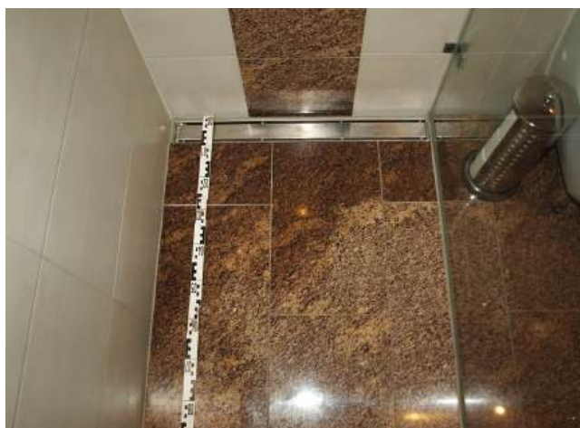
Posadzka natrysku, po wielokrotnym użyciu, z widocznymi przebarwieniami kamienia naturalnego wzdłuż pionowej krawędzi odpływu liniowego.
