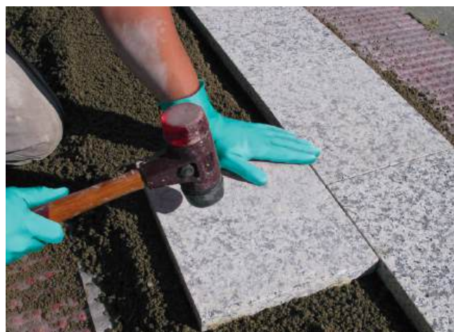
4 Ułożenie płyty kamiennej na warstwie drenażowej zaprawy grubowarstwowej, dobicie gumowym młotkiem.
