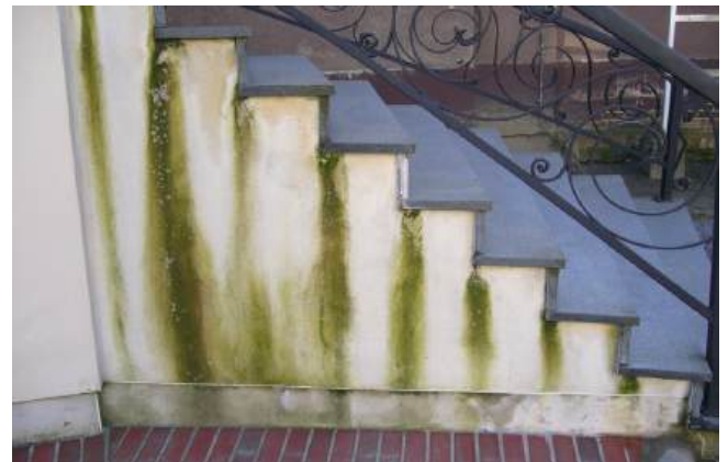
Woda wypływająca na boczne powierzchnie schodów powoduje uszkodzenia i nieestetyczne zabrudzenia.
