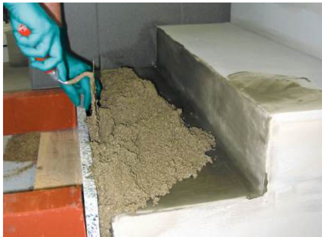
4 Osadzenie podstopnicy na zaprawie drenażowej Sopro DM 610.
