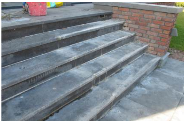
Powierzchnia tarasu odwadniana przez bieg schodów. W rezultacie powstają zabrudzenia i przebarwienia.
