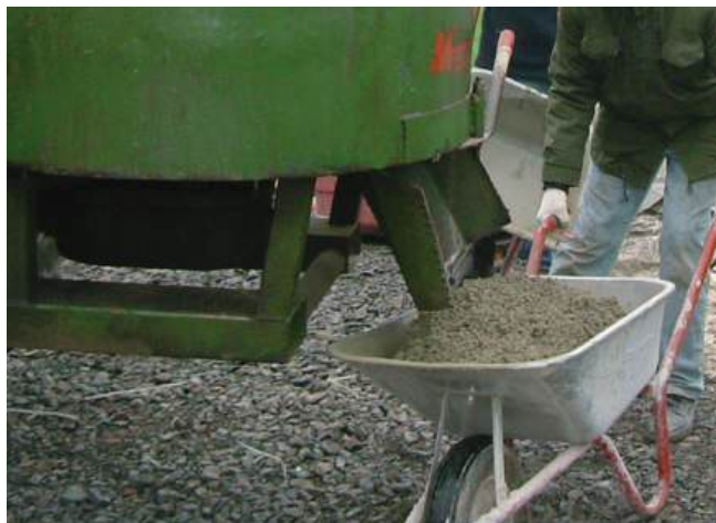
1 Mieszanie zaprawy drenażowej w betoniarnie przeciwbieżnej lub pompą do jastrychów.
