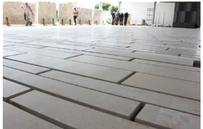
Płyty wycięte na potrzeby projektu.
