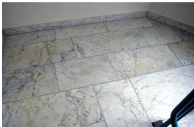
Złote przebarwienia na okładzinie, wywołane przez występujące w kamieniu związki żelaza, które mogą się uaktywnić pod wpływem wilgoci, pochodzącej z zaprawy grubowarstwowej.
