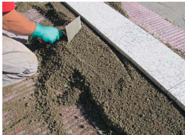
2 Wyłożenie i rozprowadzenie zaprawy drenażowej Sopro DM 610 do układania płyt kamiennych metodą „mokre na mokre”.
