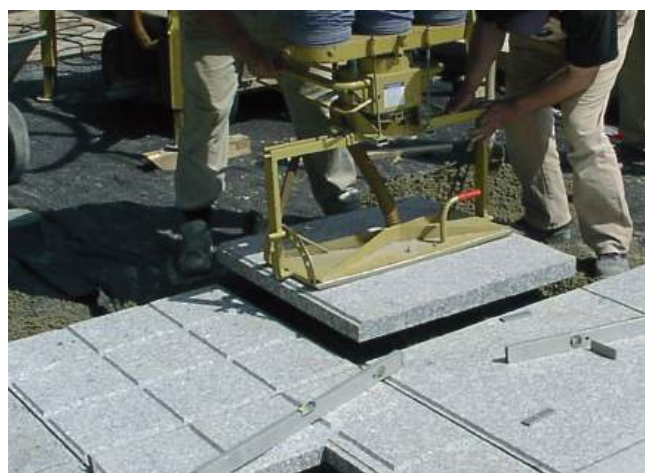
6 Ciężkie płyty wielkoformatowe układane są przy użyciu specjalnego urządzenia. Wcześniej na spód płyty została nałożona zaprawa kontaktowa Sopro HSF 748.
