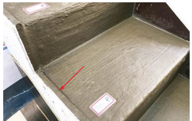
Bieg schodów z przygotowaną, ukształtowaną krawędzią.
