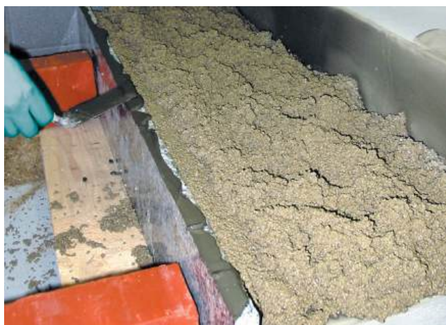
5 Warstwa zaprawy drenażowej przygotowana do osadzenia stopnicy.
