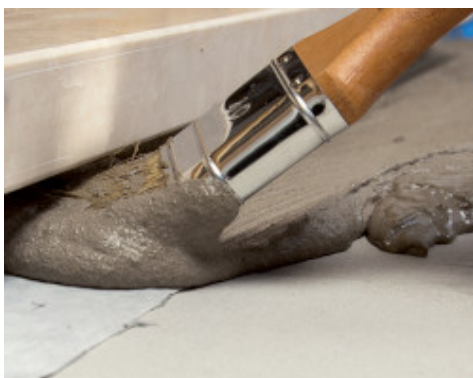
Aplikacja Mapeband SA w trudno dostępnych miejscach, np. pod schodkiem
