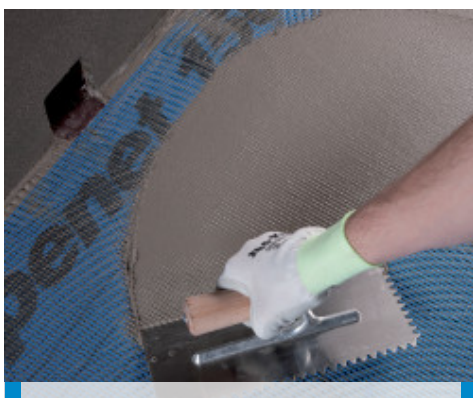
Rozprowadzanie hydroizolacji Mapelastic Zero na siatce Mapenet 150
