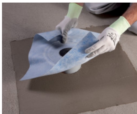
Montaż Drain Vertical na Mapelastic Zero
