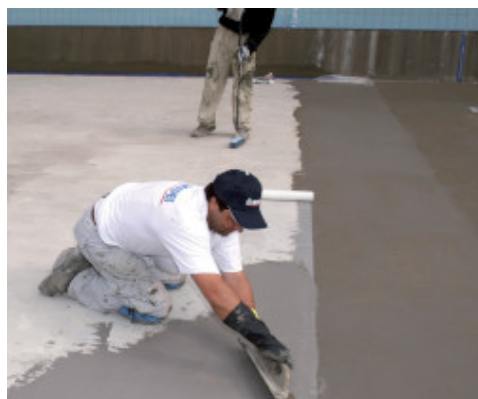
Hydroizolacja basenu z zastosowaniem Mapelastic Zero
