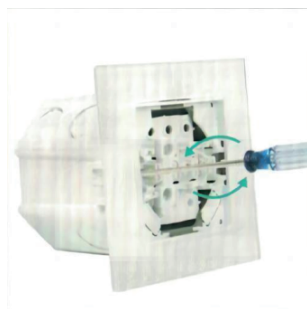
4. Umieść wyłącznik na puszcze montażowej, przekręć śrubę tak, aby hak zaczepił się o puszkę montażową
