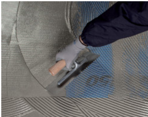
Wtapianie siatki Mapenet 150 w pierwszą, jeszcze świeżą warstwę Mapelastich Turbo
