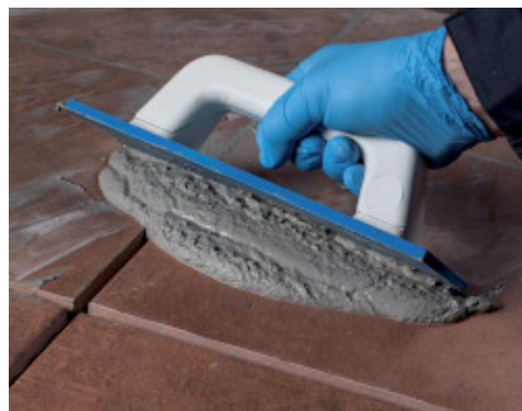
Spoinowanie płytek zaprawą do spoinowania Ultracolor Plus
