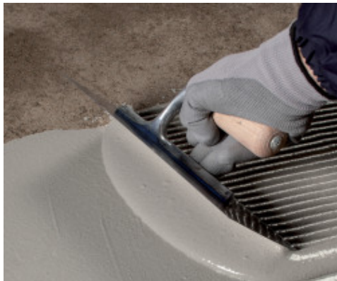
Nakładanie pierwszej warstwy Mapelastich Turbo
