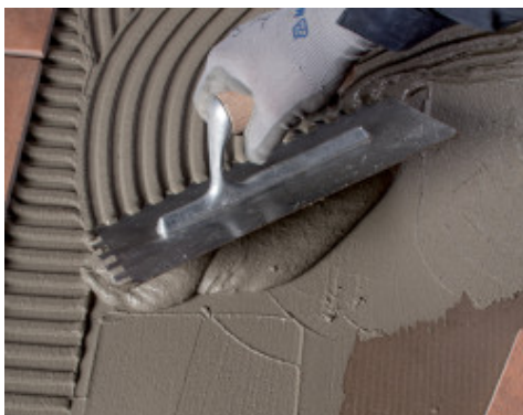
Przyklejanie płytek za pomocą zaprawy klejącej Elastorapid
