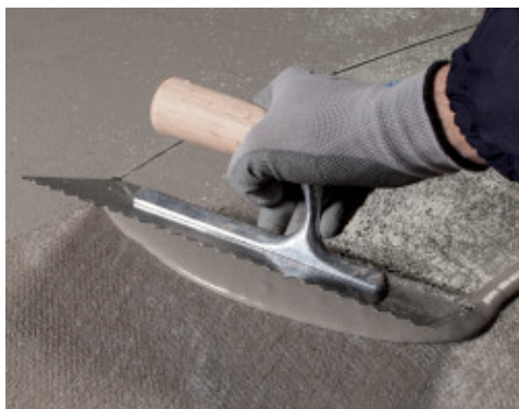
Aplikacja drugiej warstwy Mapelastich Turbo na pierwszą wzmocnioną Mapetex Sel N
