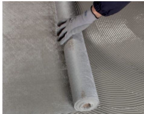
Układanie Mapetex Sel N na pierwszej, jeszcze świeżej warstwie Mapelastich Turbo
