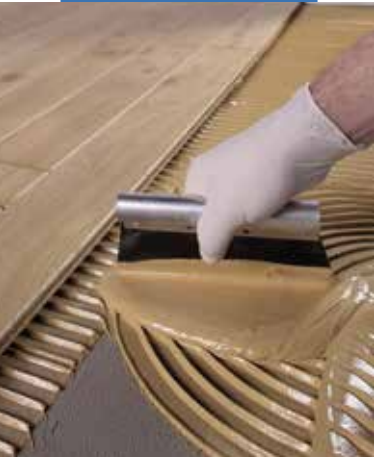
Rozprowadzanie Ultrabond P990 1K
