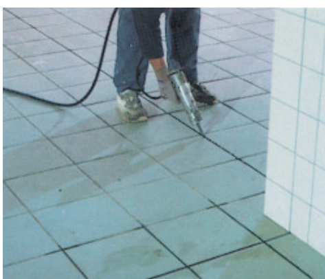
Spoinowanie posadzki za pomocą pistoletu pneumatycznego
