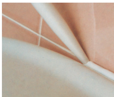
Spoinowanie ceramiki sanitarnej przy użyciu Mapesil AC
