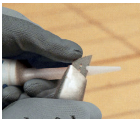
Przycinanie dyszy w zależności od wymiaru szczeliny
