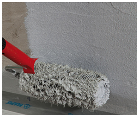
Nanoszenie warstwy Mapegum WPS wałkiem
