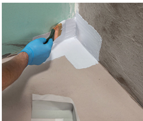
Przyklejanie narożnika Mapeband PE 120 na Mapegum WPS
