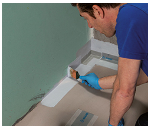
Przyklejanie taśmy Mapeband PE 120 na Mapegum WPS
