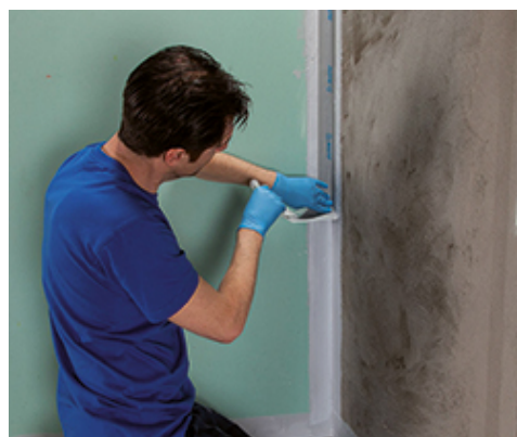
Przyklejanie taśmy Mapeband PE 120 na Mapegum WPS
