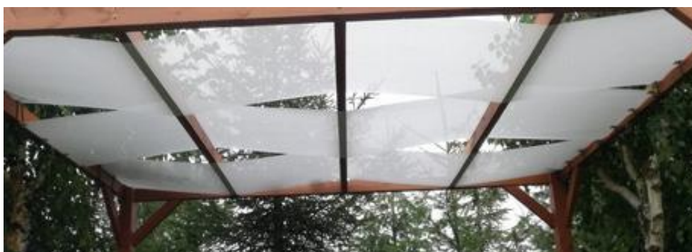
Rysunek 2. Proponowany sposób montażu pasów.
