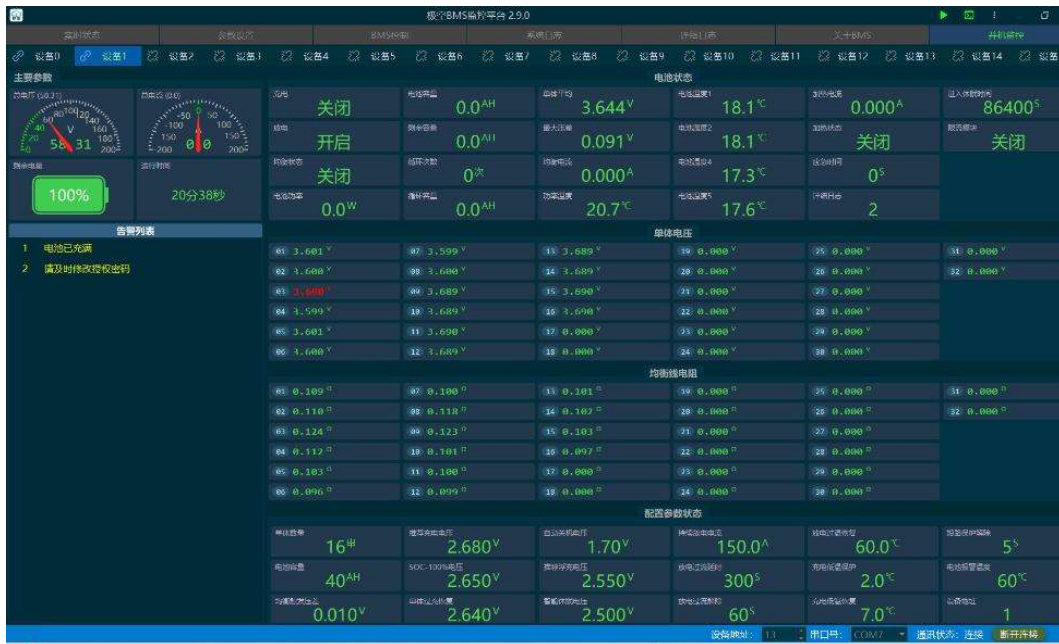
Widok monitorowania BMS nr 2
