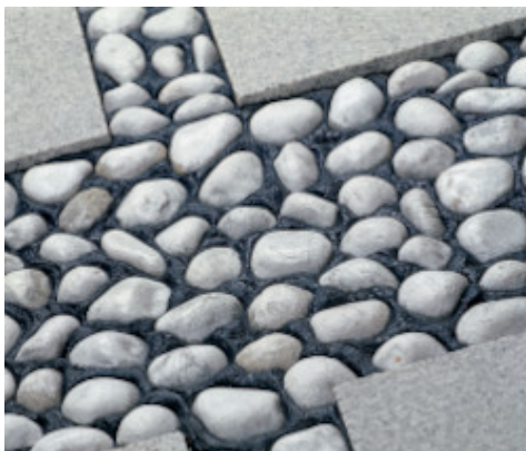
Spoinowanie dekoracyjnej posadzki kamiennej
