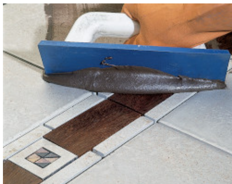
Spoinowanie posadzki ceramicznej z elementami drewnianymi przy użyciu pacy MAPEI
