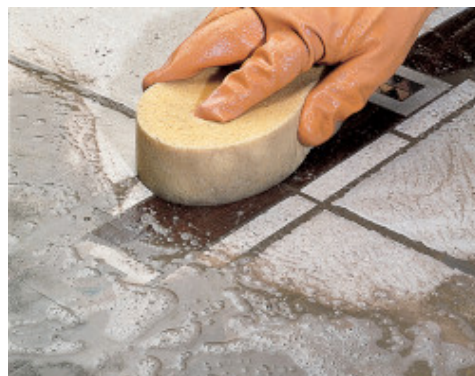
Profilowanie posadzki ceramicznej z elementami drewnianymi przy użyciu gąbki
