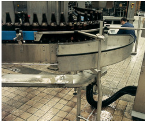
Przykład posadzki w browarze, zaspoimowanej z użyciem Kerapoxy
