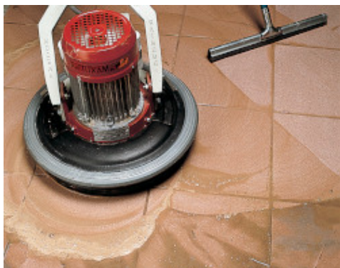
Czyszczenie podłogi z gresu porcelanowego przy użyciu maszyny czyszczącej i rakli
