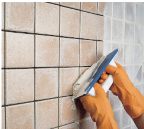
Spoinowanie płytek glazurowanych
