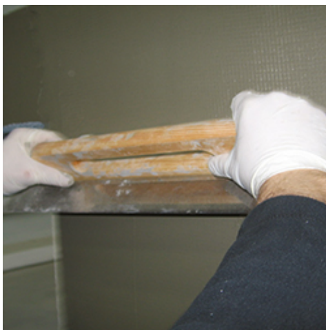
Wyrównywanie warstwy zaprawy Mapetherm do siatki z zatopioną siatką szklaną
