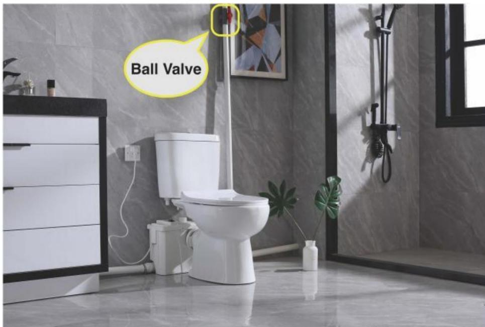
(5-4), Installeer een kogelkraan (niet meegeleverd) in de buurt van de wateruitlaat om lekkage van rioolwater te voorkomen wanneer de pomp wordt gedemonteerd.
