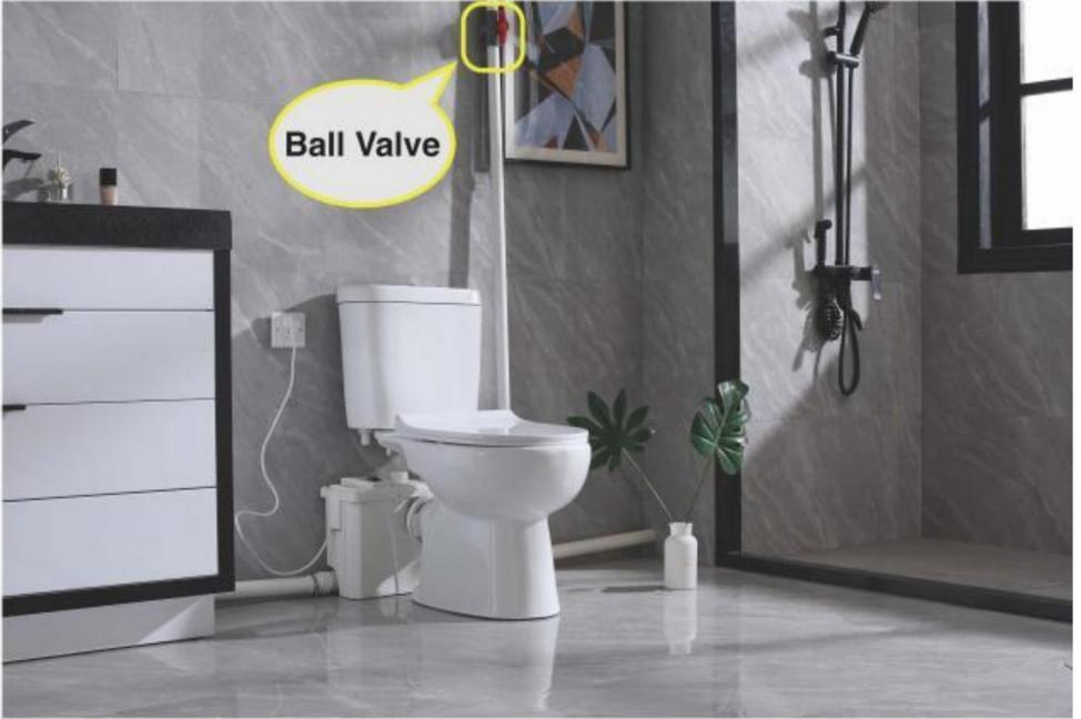
(5-4). Instale una válvula de bola (no incluida) cerca de la salida de agua para evitar fugas de aguas residuales cuando se desmonte la bomba.
