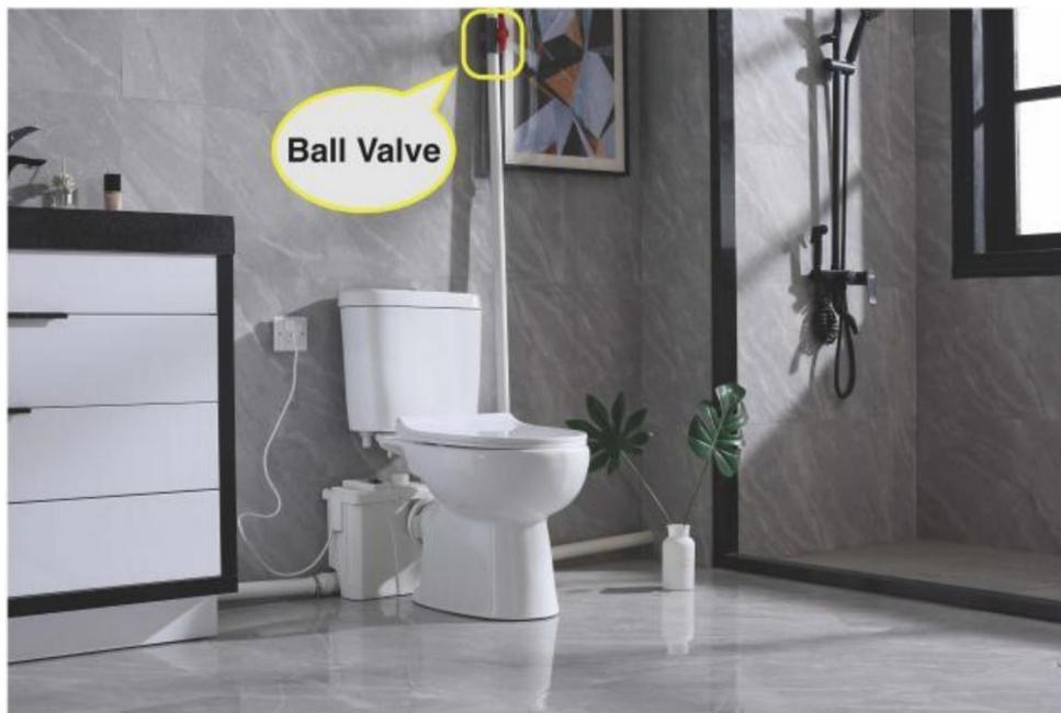
(5-4), installare una valvola a sfera (non fornita) vicino all'uscita dell'acqua per evitare perdite di liquami quando la pompa è smontata.
