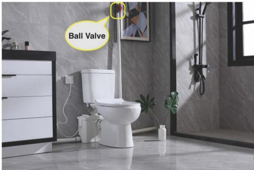
(5-4), Installera en kulventil (medföljer ej) nära vattenutloppet för att förhindra avloppsläckage när pumpen demonteras.
