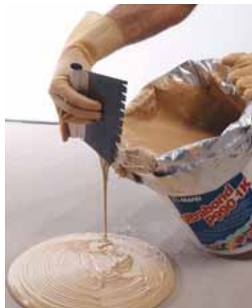
Oczyszczanie obrzeża wiadra z kleju przy pomocy szpachelki
