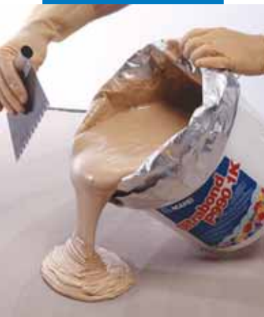
Wylewanie kleju na podłoże
