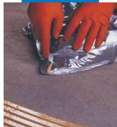
Metoda alternatywna użycia opakowania: nacięcie worka w dolnym rogu
