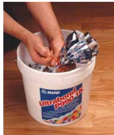
Uszczelnienie aluminiowego worka przy pomocy specjalnej taśmy umieszczonej w wiaderku
