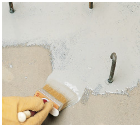
Nanoszenie kleju Eporip pędzlem
