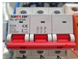
N L1 L2 L3 ROZŁĄCZNIK IZOLACYJNY WEJŚCIE ZASILANIA Z SIECI
