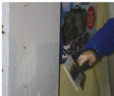
Dobijanie płyty styropianowej podczas instalacji
