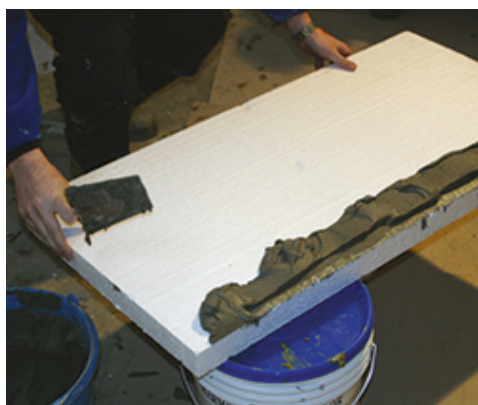
Nakładanie kleju Mapetherm do styropianu na płytę izolacyjną
