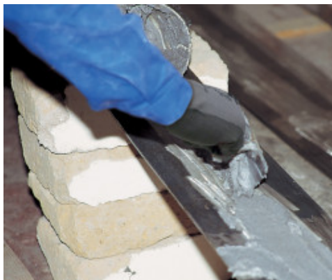
Nanoszenie Adesilex PG1 na powierzchnię stalowego płaskownika
