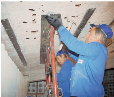
Wzmacnianie konstrukcji przez przyklejenie stalowego płaskownika
