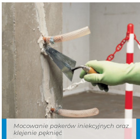
Nanoszenie Adesilex PG1 na powierzchnię kolumny
