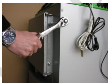
Fot.6. Zdemontować drzwiczki z włazu.
