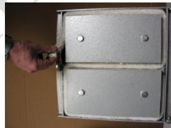
Fot.9. Wymiana uszczelki ceramicznej drzwiczek
