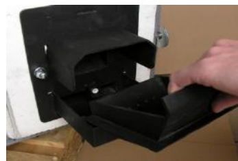
Fot.3. Czyszczenie tygla palnika QPel
