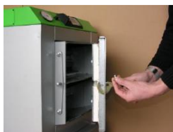
Fot.5. Wyjąć podzespoły mocowania uchwyty.
