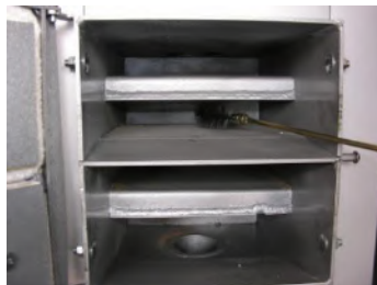
Fot.5. Powierzchnie wymiennika czyścić szczotką lub odkurzaczem.
