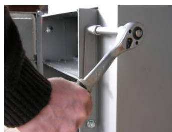
Fot.9. Zamontować rygiel po drugiej stronie.
