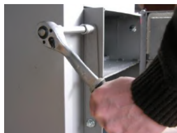
Fot.8. Regulacja rygla zamka (poluzować śruby, ustawić rygiel, dokręcić śruby).
