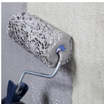
Warstwa kontaktowa nakładana wałkiem
