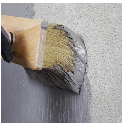
Warstwa kontaktowa nakładana pędzlem.
