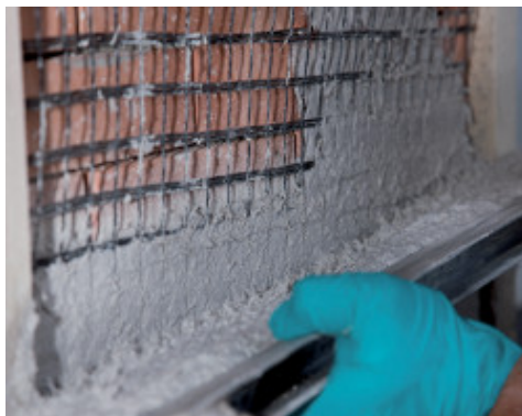
Nakładanie Planitop HDM Restauro w połączeniu z siatką Mapegrid G 220 na powierzchnię muru
