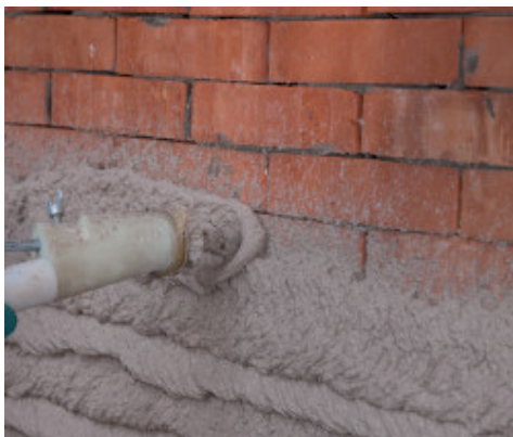
Nakładanie Planitop HDM Restauro natryskowo na powierzchnię muru
