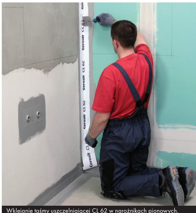
Wklejanie taśmy uszczelniającej CL 62 w narożnikach pionowych.
