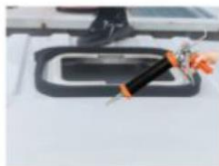
Nałóż gąbkę i uszczelniając
