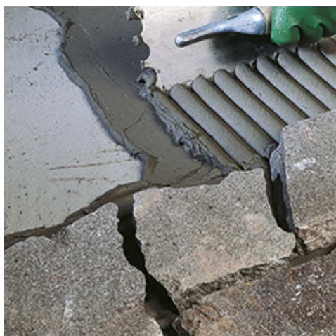
Montaż płytek klinkierowych na zewnątrz
