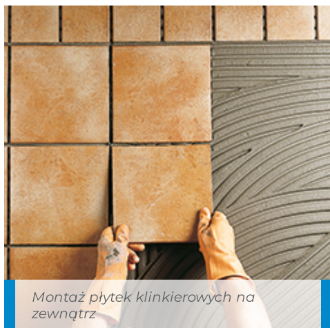
Układanie ręcznie wykonanej terakoty na nierównym podłożu
