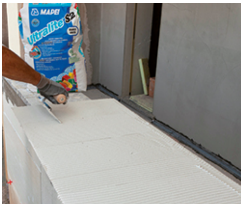
Rozprowadzanie kleju na spodniej stronie płytki
