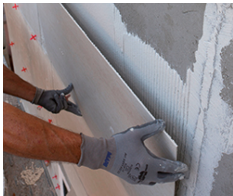
Montaż płyty z cienkiego gresu porcelanowego na elewacji
