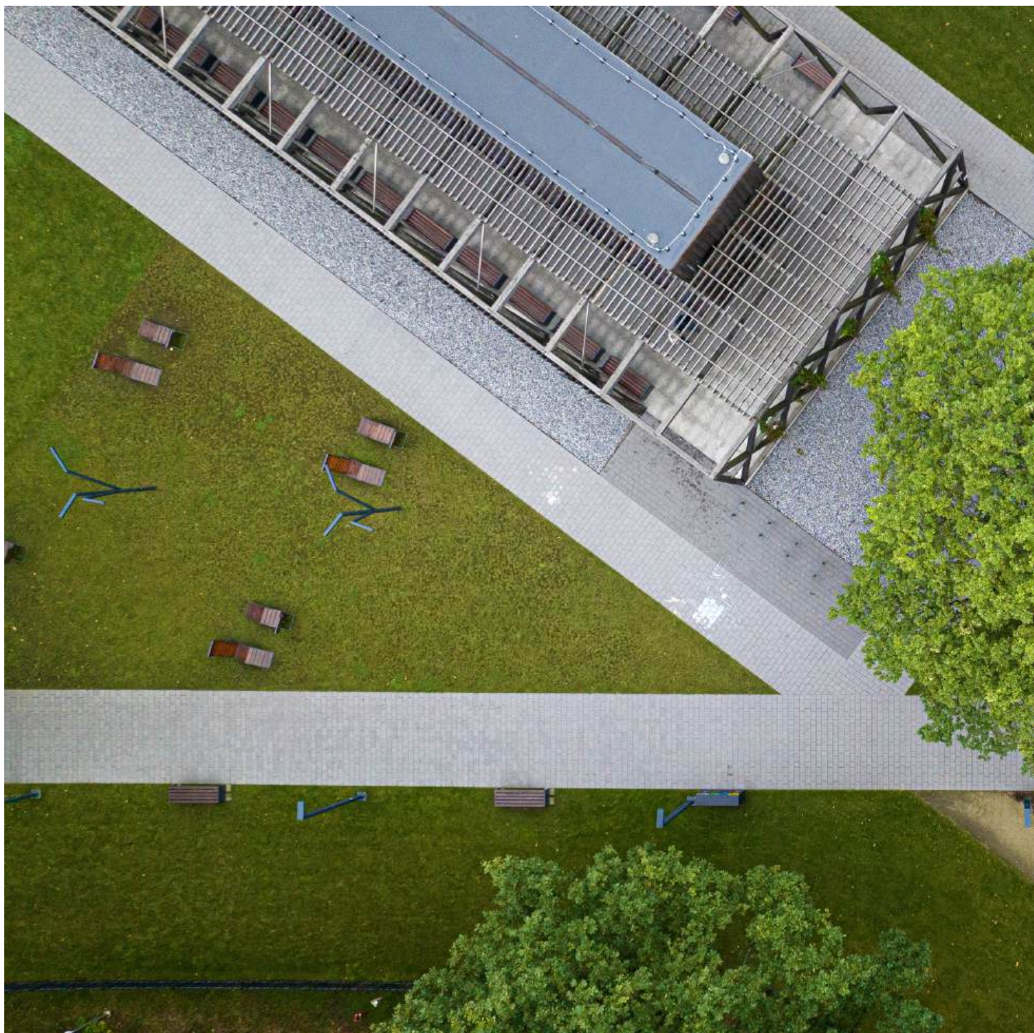
Gliwice, Tężnia, płyty brukowe Senso, kolor platino
