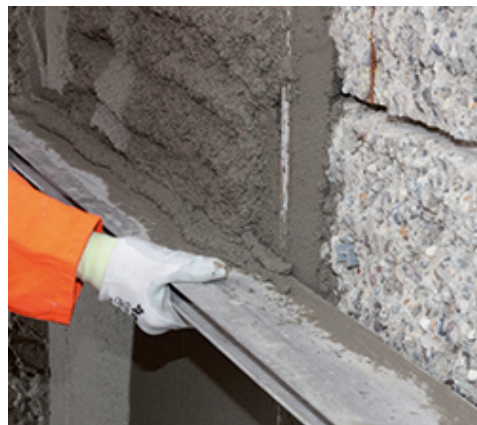
Wyrównywanie powierzchni łatą
