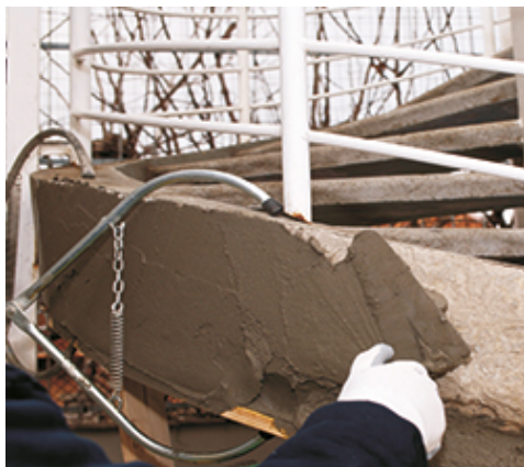
Nanoszenie Mapegrout 430 pacą
