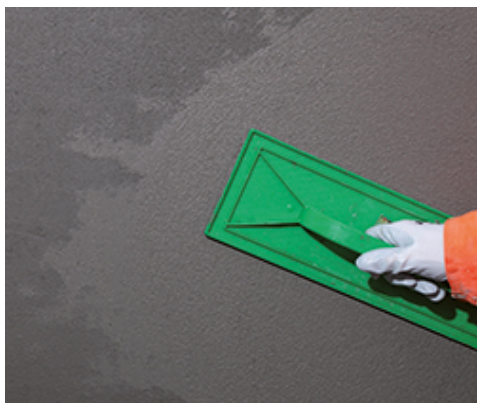
Zacieranie powierzchni Mapegrout 430
