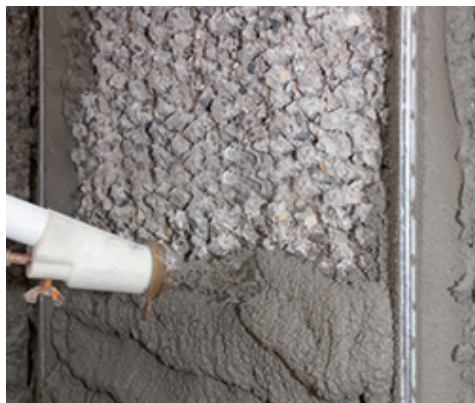
Nanoszenie Mapegrout 430 maszynowo
