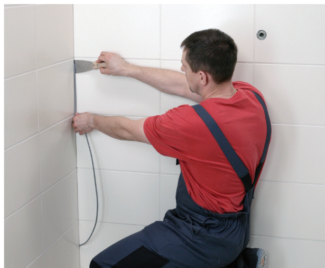
Umieszczanie sznura dylatacyjnego w spoinie
