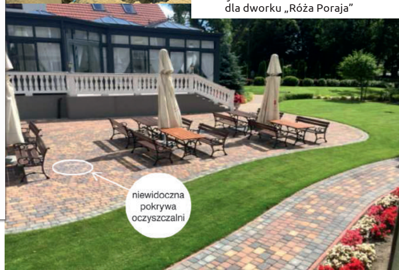
Oczyszczalnia zainstalowana dla dworku „Róża Poraja”
