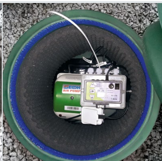
Skrzynka techniczna z wygłuszeniem
