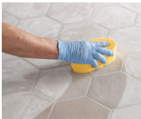
Czyszczenie i profilowanie spoin twardą celulozową gąbką
