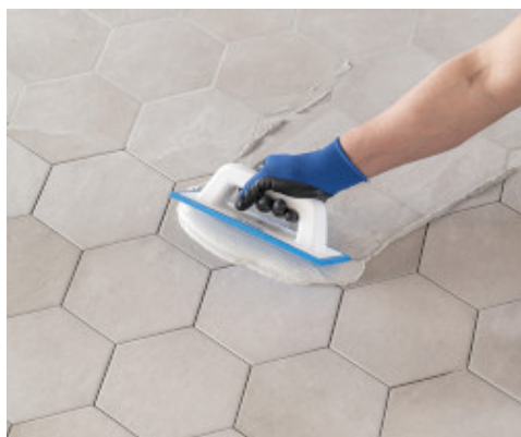
Rozprowadzanie Keracolor FF za pomocą pacy MAPEI
