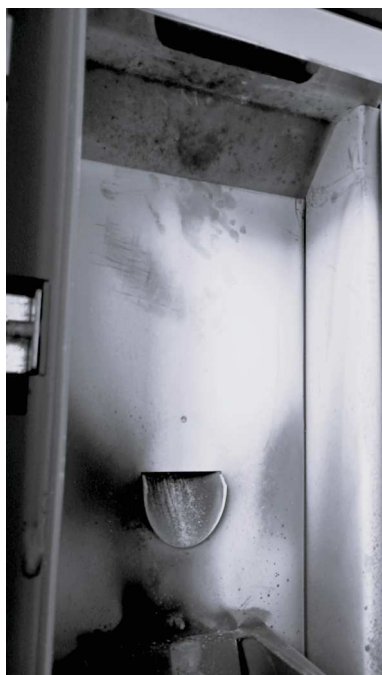
Rys. 22 - Demontaż głowicy paleniska 1
