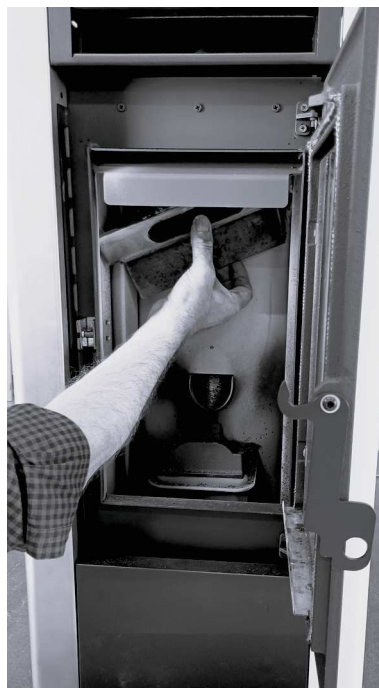
Rys. 23 - Zdejmowanie głowicy paleniska 2
