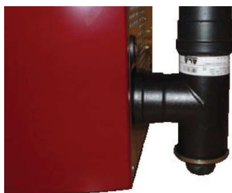
Rys. 21 - Czyszczenie przewodu spalin
