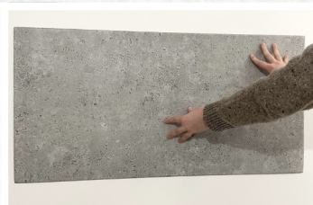
5. Wyrównaj krawędzie i układaj panele w kolejności
