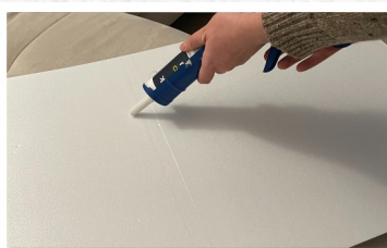
4. Użyj kleju do sztukaterii ściennej punktowo lub liniowo rozprowadzając go
