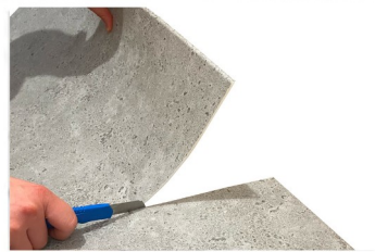
3. Dotnij panel ścienny wdg. własnych obliczeń za pomocą nożyka tapicerskiego
