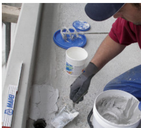
Nakładanie Adesilex PG4 szpachelką
