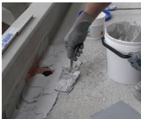
Nanoszenie kleju na wierzch kołnierza odpływowego
