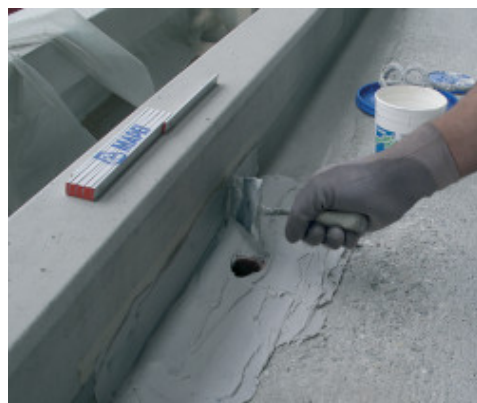
Nakładanie końcowej warstwy Adesilex PG4
