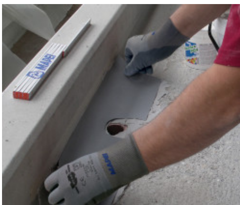
Wklejanie elastycznej taśmy hypalonowej
