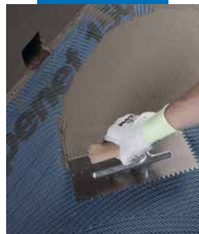
Rozprowadzanie hydroizolacji Mapelastic na siatce Mapenet 150
