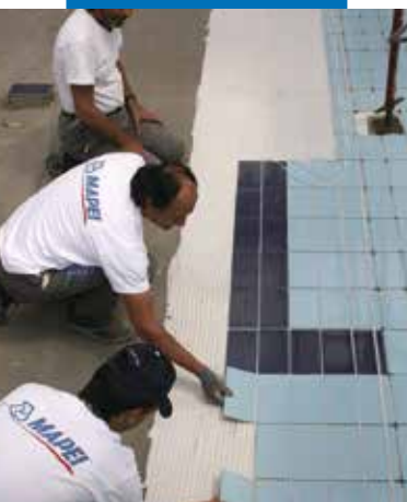
Montaż płytek ceramicznych na warstwie hydroizolacji Mapelastic
