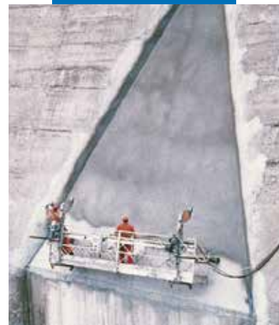
Nanoszenie Mapelastic metodą natryskową na zaporze wodnej
