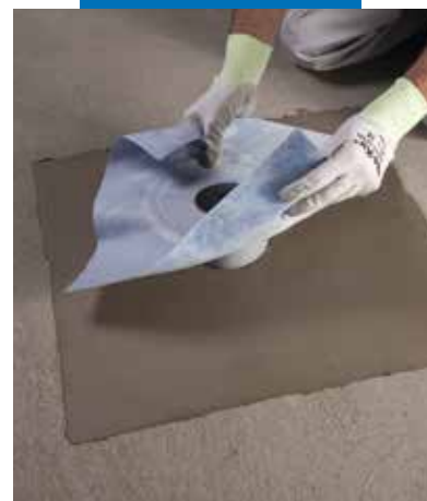
Montaż Drain Vertical na Mapelastic
