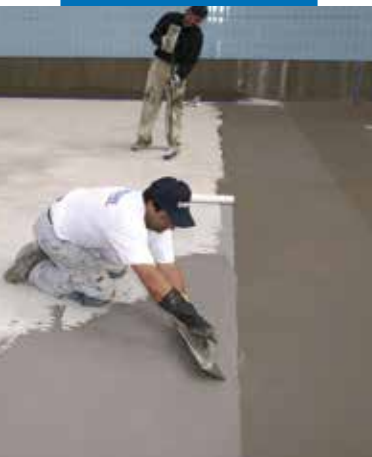
Hydroizolacja basenu z zastosowaniem Mapelastic
