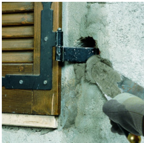
Zastosowanie Lampocem do mocowania śrub kotwiących okienne
