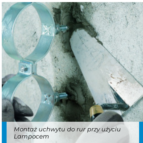
Mocowanie elementów instalacji elektrycznej z zastosowaniem Lampocem
